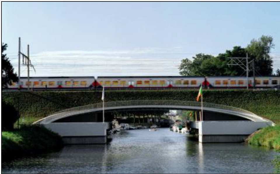
Passage inférieur “Snepbrug” sur la Lys
